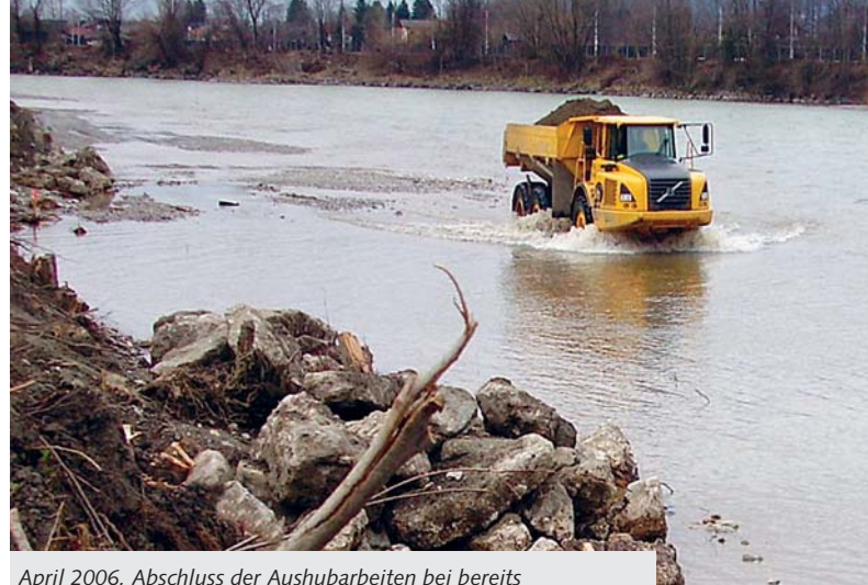
April 2006, Abschluss der Aushubarbeiten bei bereits erhöhtem Wasserstand in der Salzach/Flussaufweitung Torren.
