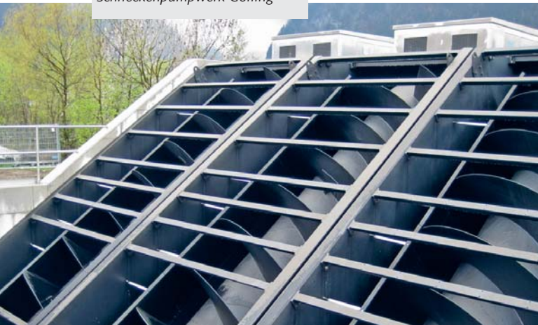
Schneckenpumpwerk Golling
