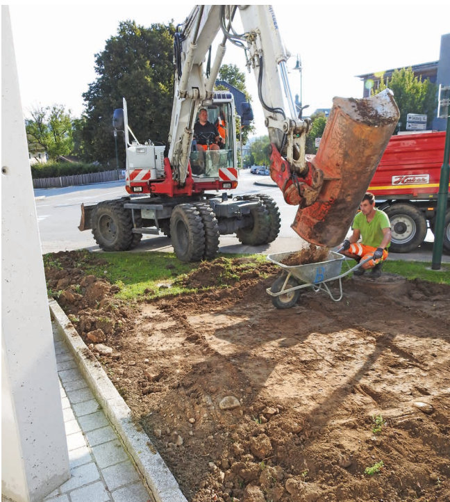
Rasensoden und je nach Beschaffenheit Boden abtragen.
