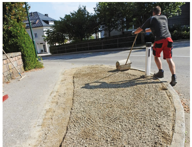
Anwalzen des Saatguts für einen guten Bodenschluss.
