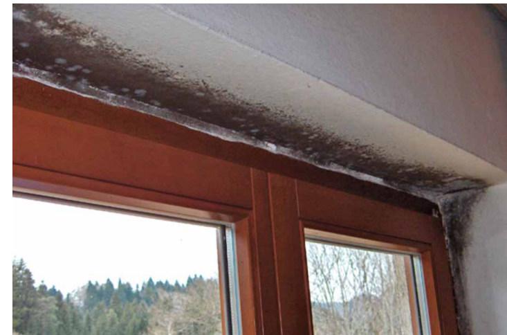
Schimmelbildung in der Fensterlaibung, typische Ursache: gekipptes Fenster im Winter
